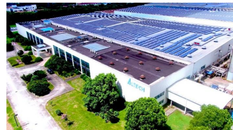
2021年に蘇州工場に設置された太陽光パネル
