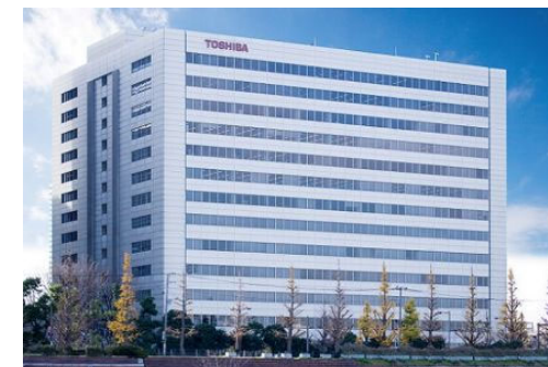
川崎東芝ビル（神奈川県川崎市）
