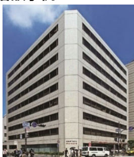
パシフィックマークス 肥後橋
