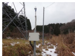
鉄塔や周辺地盤の変動監視
