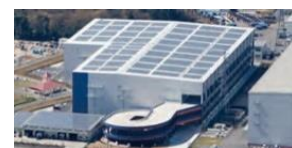
太陽光パネルの設置
