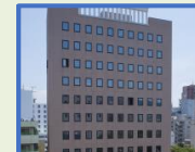
長野セントラルビル
