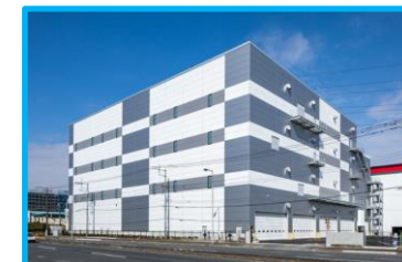
グループ初の物流施設 「野田市中里物流施設」 (2022年3月竣工)
