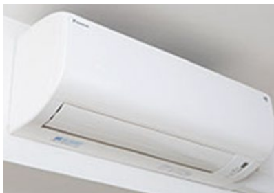
空調設備の更新
