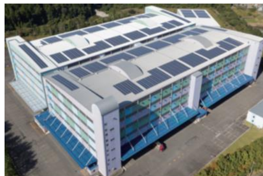
取得済物件 いなべロジスティクスセンター
