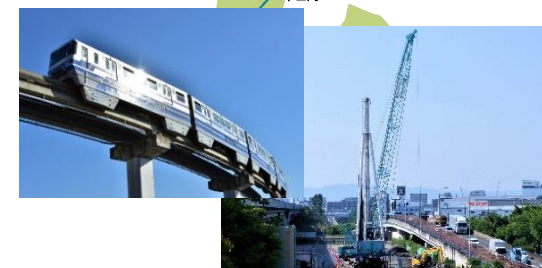
大阪モノレール支柱建設工事（桑才新町工区）
