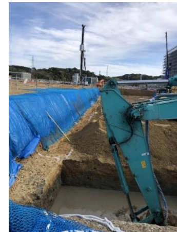
TENO Q-be とテノコラム併用の施工の様子
