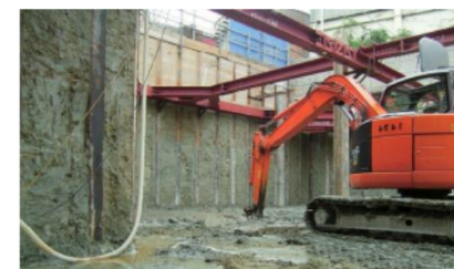
TENO Q-be 切梁下部での施工
