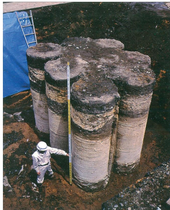
地盤改良工法
