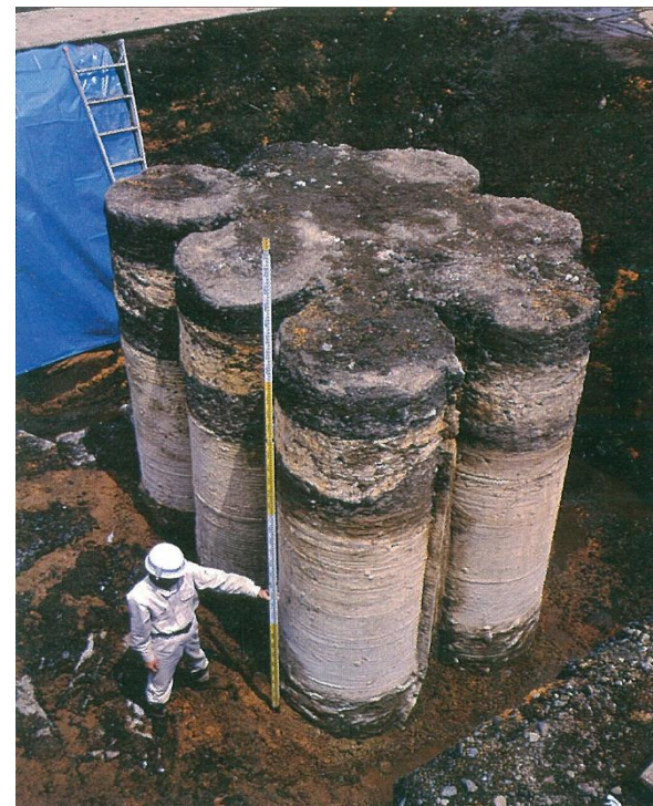
地盤改良工法
