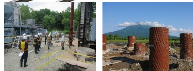
北海道新幹線鋼管ソイルセメント杭施工試験
