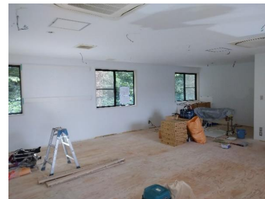
テノックス技研事務所改修工事
