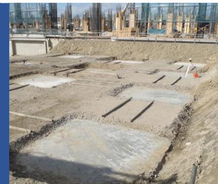
湿式浅層改良工法の施工状況
